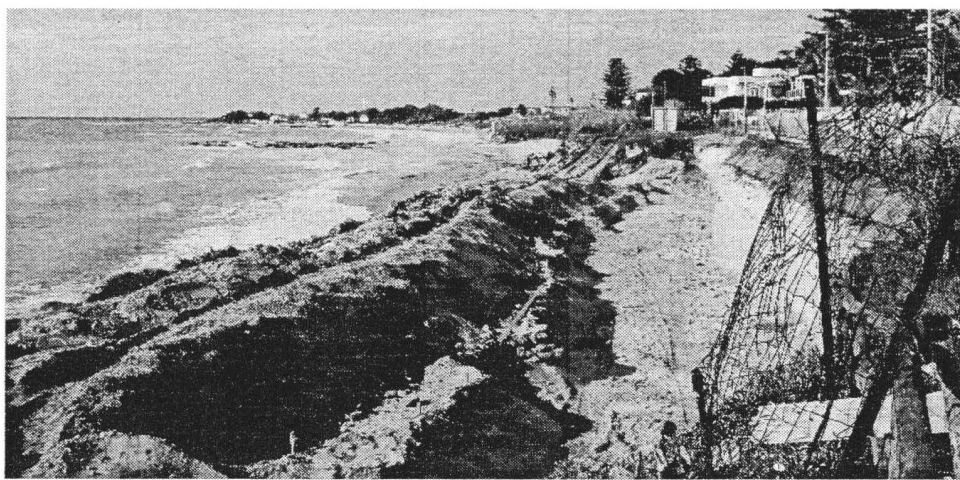
Primi lavori alla spiaggia delle Anticaglie di Punta Secca. FOTO MARCELLO DIGRANDI
